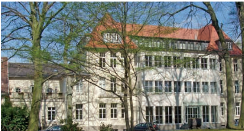
Verwaltungsgebäude Mülheim an der Ruhr
