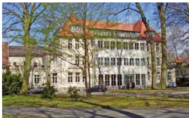
Bâtiment administratif à Mülheim dans la région de la Ruhr
