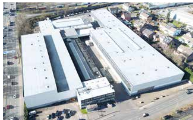
Halls de production à Leverkusen
